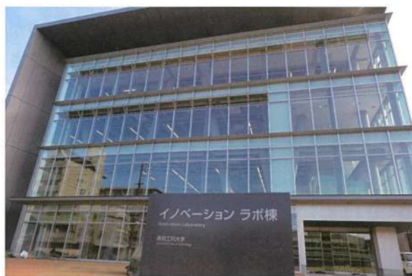
イノベーション ラボ棟 学群の拠点などとして2026年4月から稼働 (高知市永国寺町)
